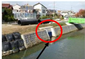
Q: 福岡郵便局横に流れる砂川に新設された樋門の高さが水面との高さと同じだが、防災上問題ないか？
