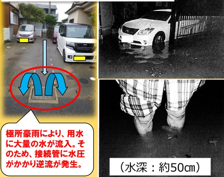
極所豪雨により、用水に大量の水が流入。そのため、接続管に水圧がかかり逆流が発生。
